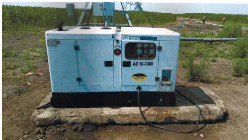
Рисунок 1.4 – Электрогенераторная установка AD10-T400 для электроснабжения дождевальной машины
